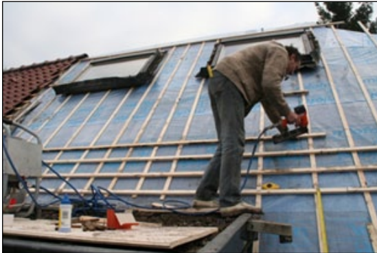
Nagels of schroeven voor bevestiging panlat
